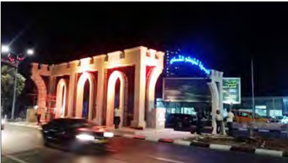
لظة من مدخل مدينة البيرة الجنوبي عقب انجاز مشروع أعمال تاهيل وتعبيد شارع القدس البيرة.
